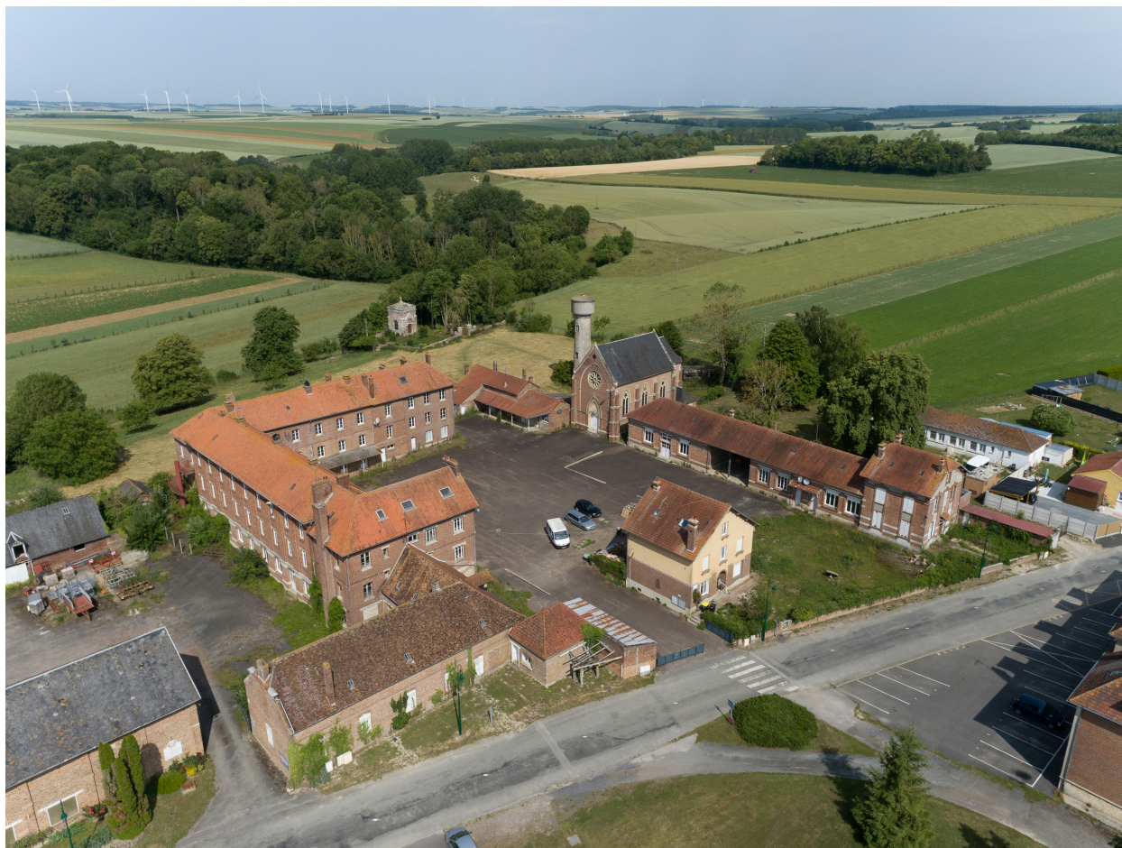
Vue aérienne de la cour nord depuis l'est.
