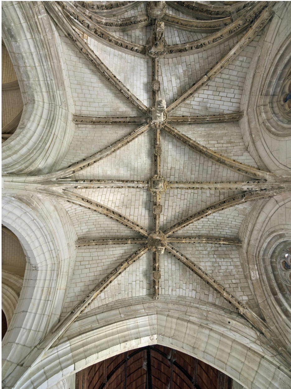
Voûte de la chapelle de la Vierge, deuxième et troisième travées.
