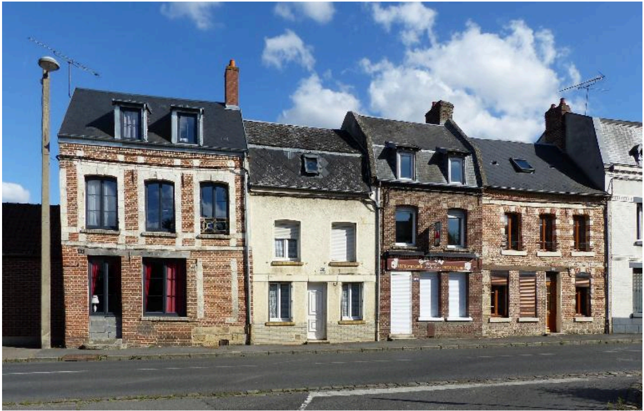
Maisons, 47 à 55 rue Saint-Fursy.
