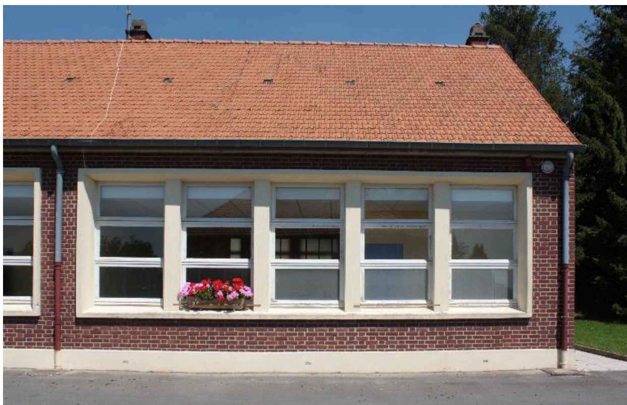
Détail d'une travée, façade sud.
