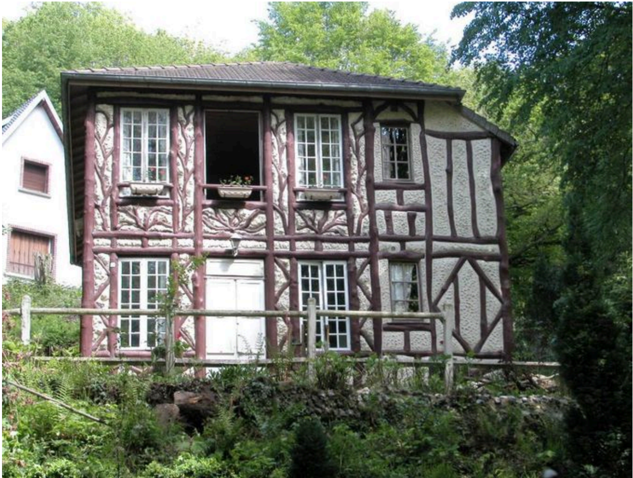
Vue d'ensemble avant changement des huisseries.
