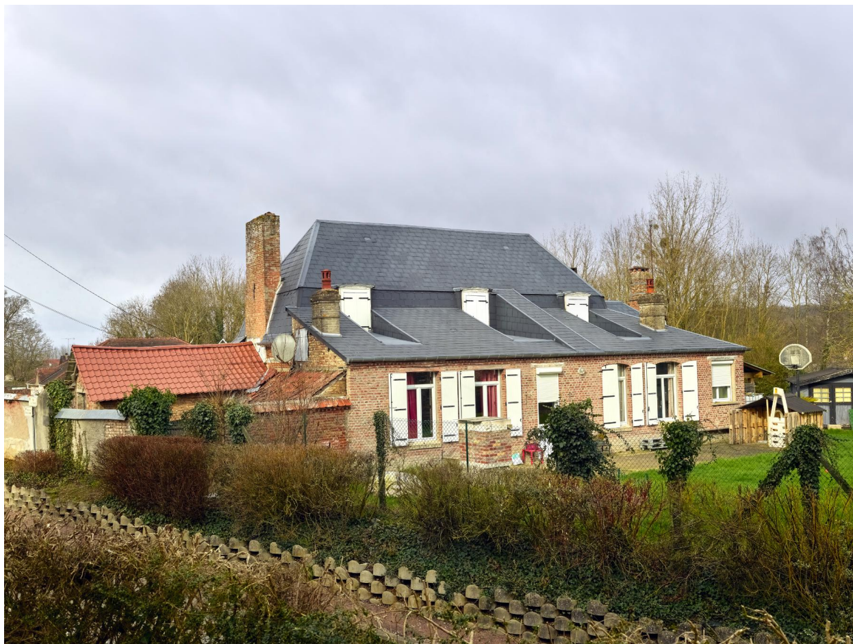
Façade sud-est de la maison, depuis le sud.
