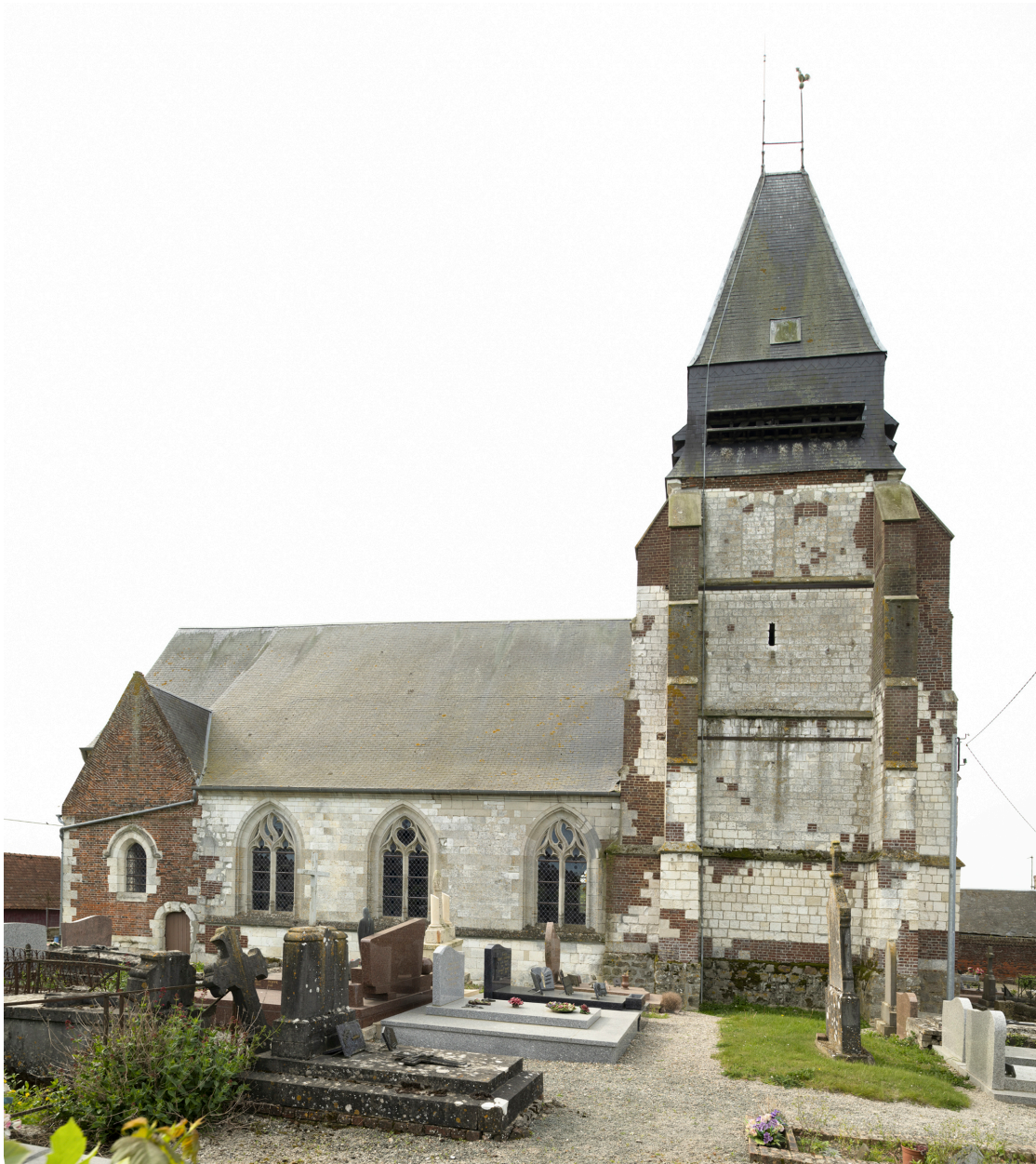
Vue générale de l'élévation nord.
