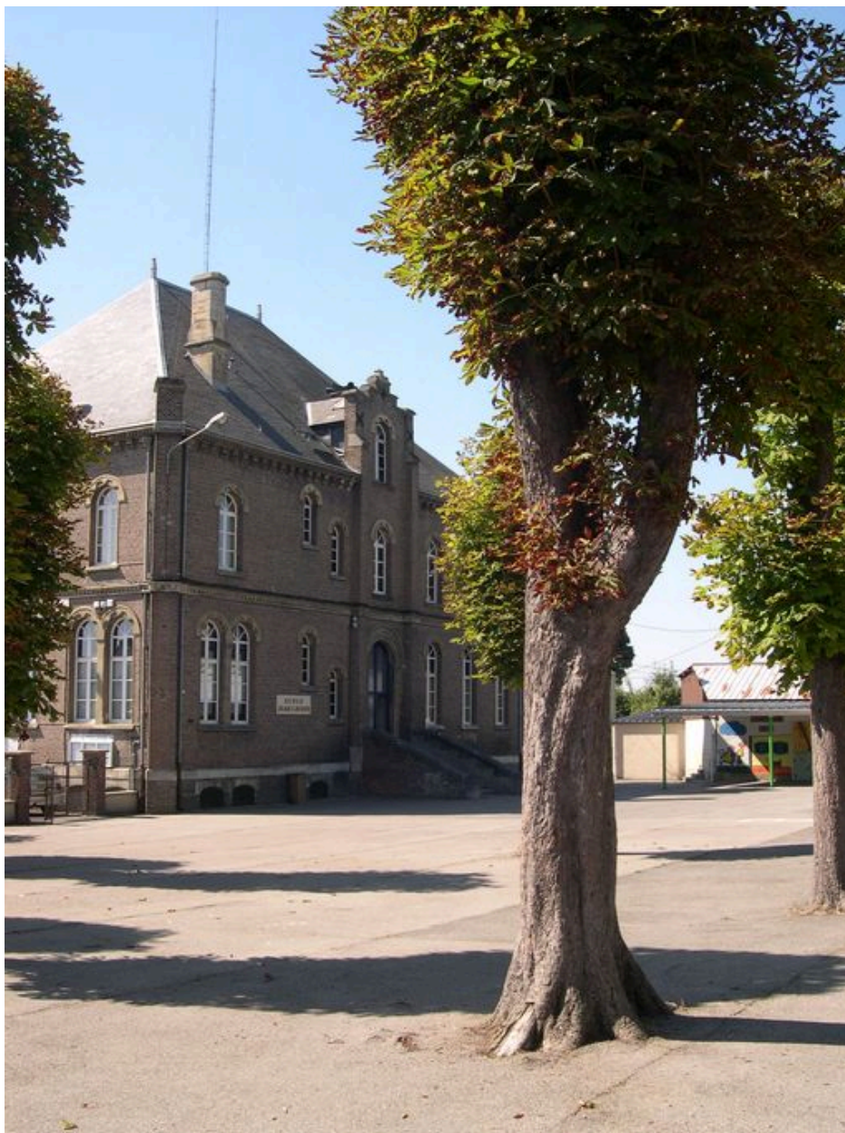
Vue de la façade nord et de la cour d'école.
