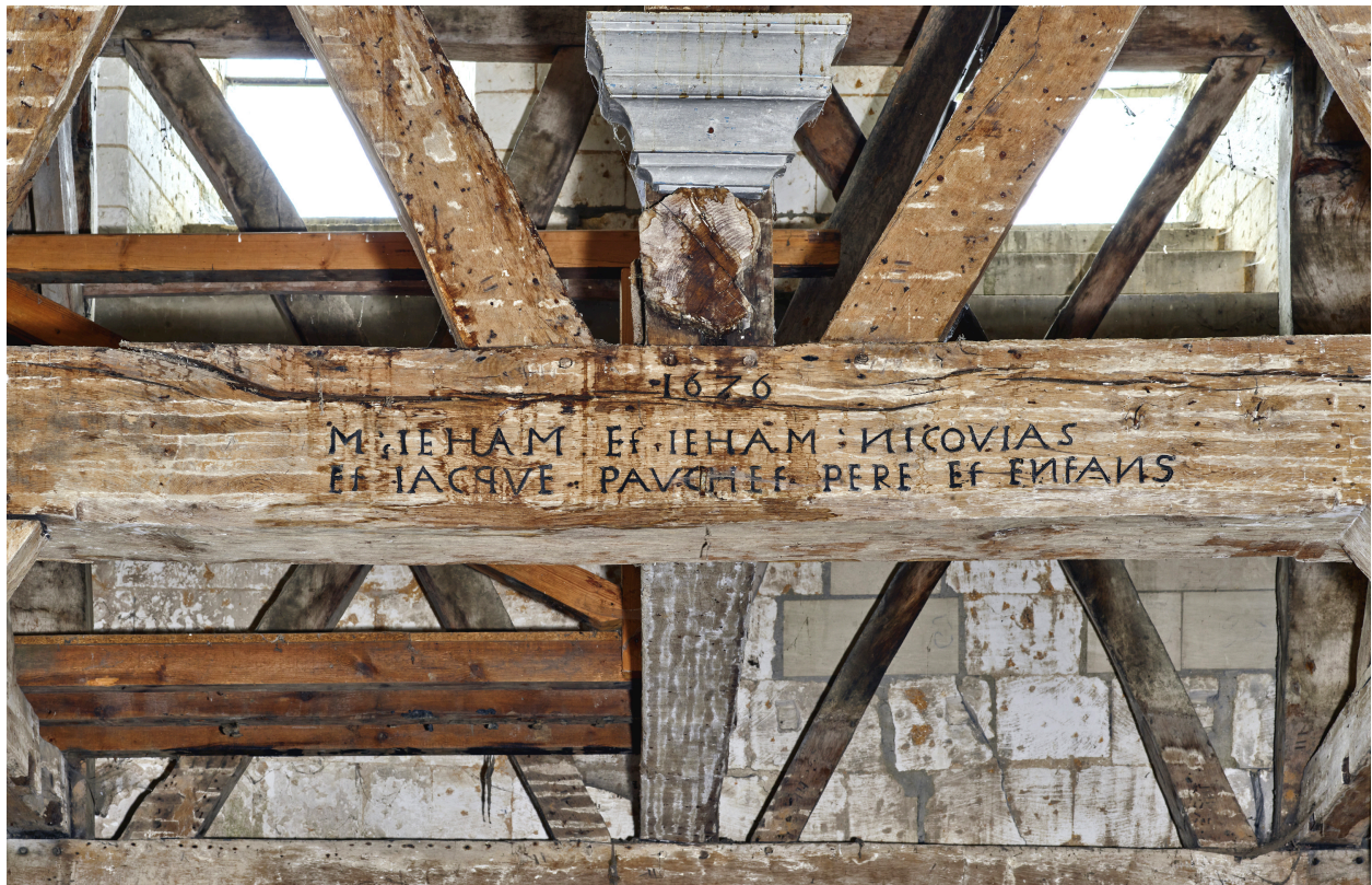
Intérieur, date et inscription sur la structure du clocher.
