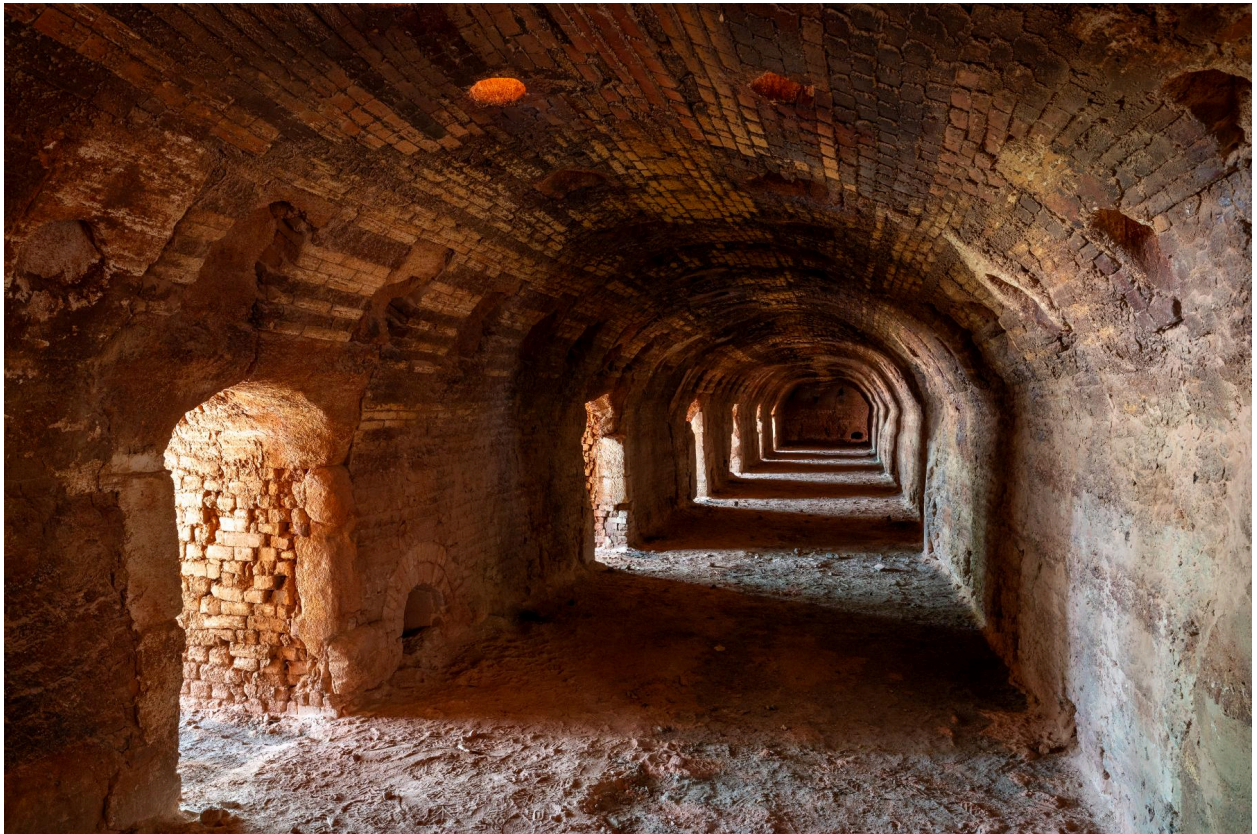
Four Hoffmann. Galerie de cuisson des briques.
