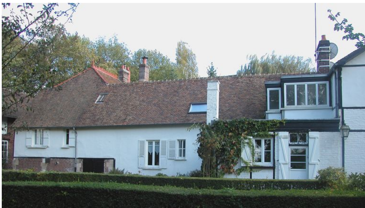
Façade postérieure du logement patronal.
