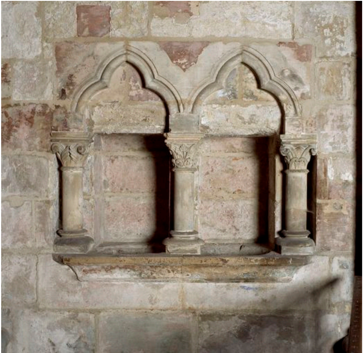
Vue du lavabo en niche de la chapelle axiale.
