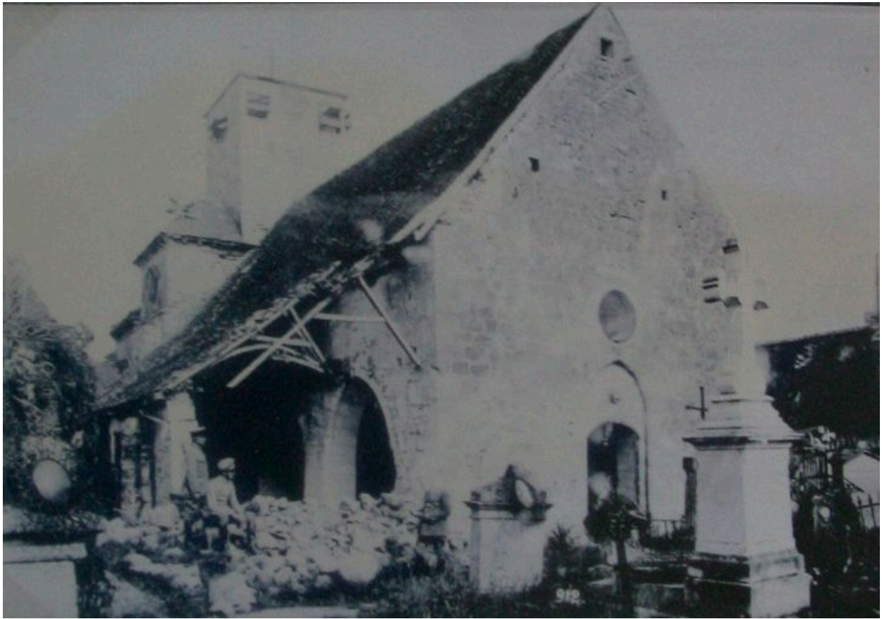
Vue de l'église de Juvincourt au début des conflits (coll. part).
