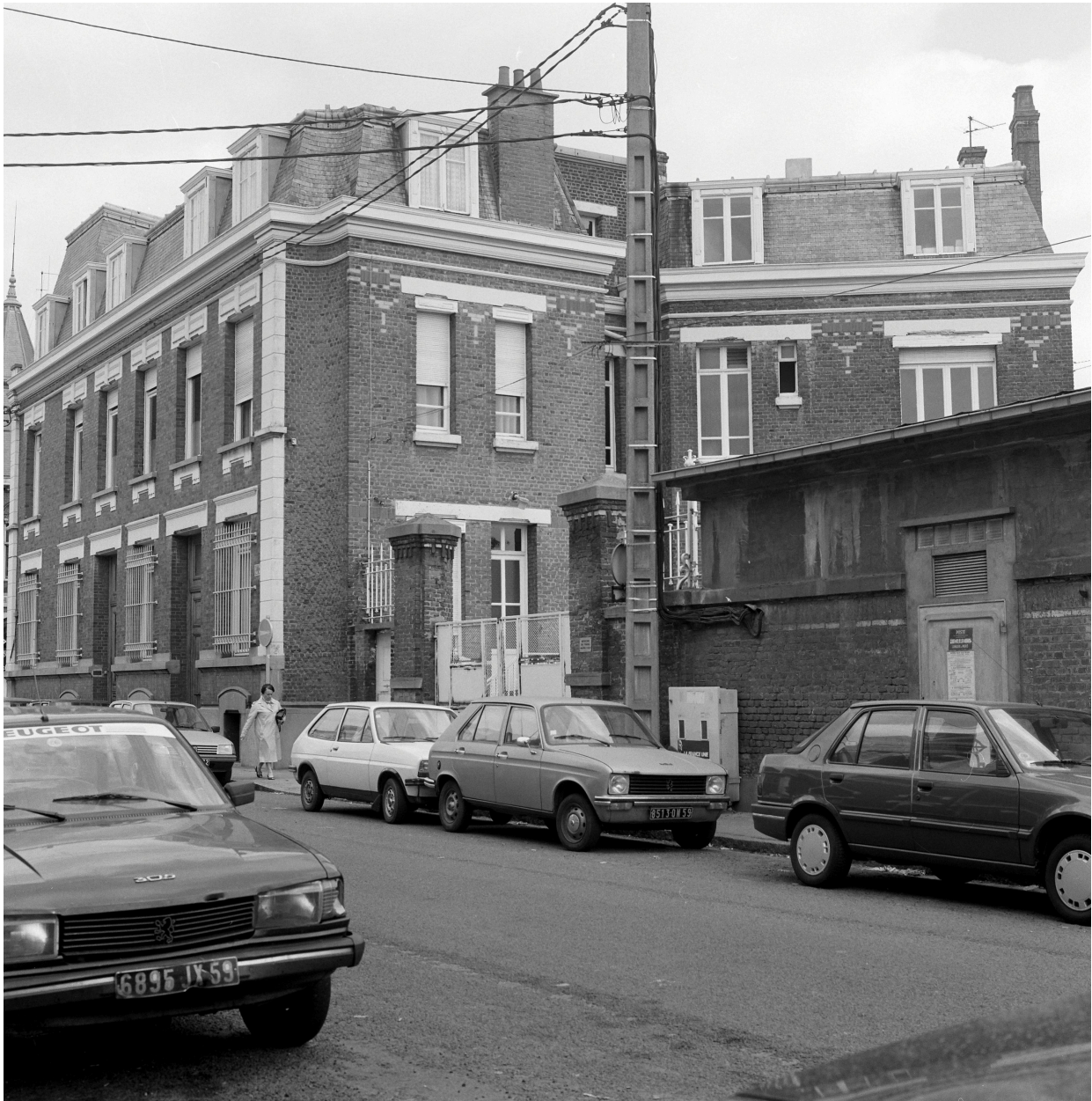
Élévation postérieure. Bureaux.
