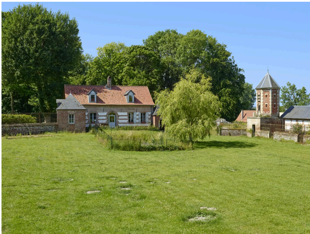
Logement du fermier et pigeonnier vus depuis la cour.
