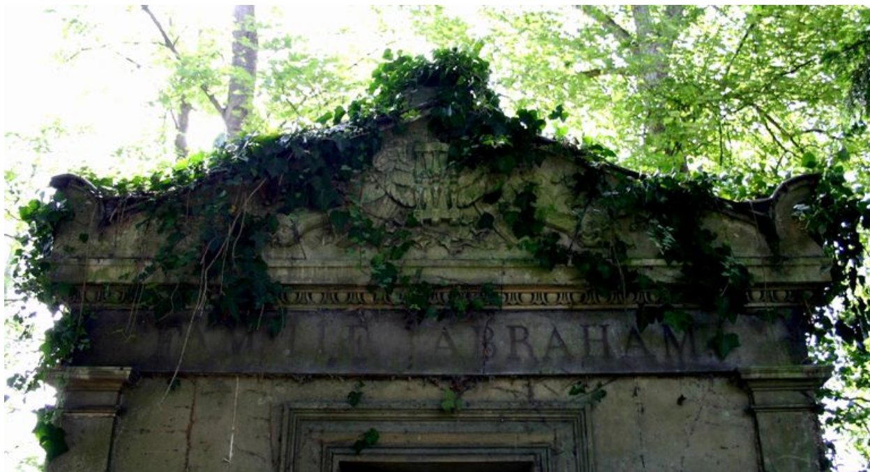
Fronton ornant la façade antérieure du tombeau-chapelle.
