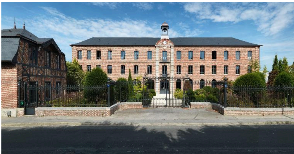
Vue des anciens ateliers de fabrication de l'usine Laperche, aujourd'hui Showroom de l'entreprise Delabie.
