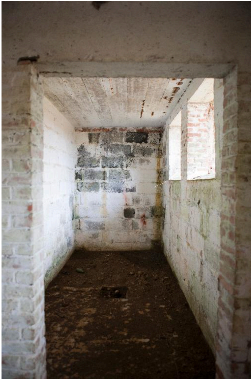
Abri casernement : vue intérieure.
