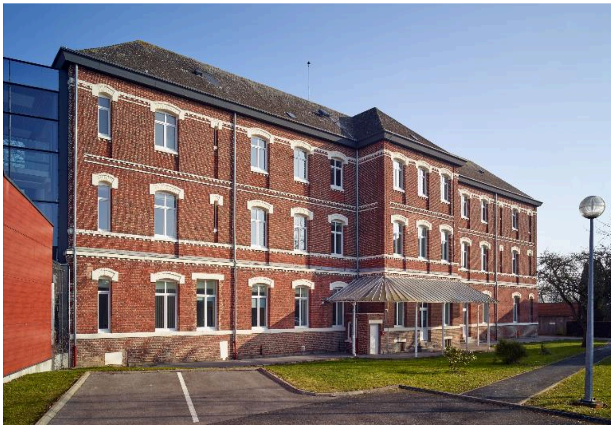
Bâtiment d'hospitalisation dit pavillon 10, élévation postérieure, vue générale prise de trois quarts gauche.
