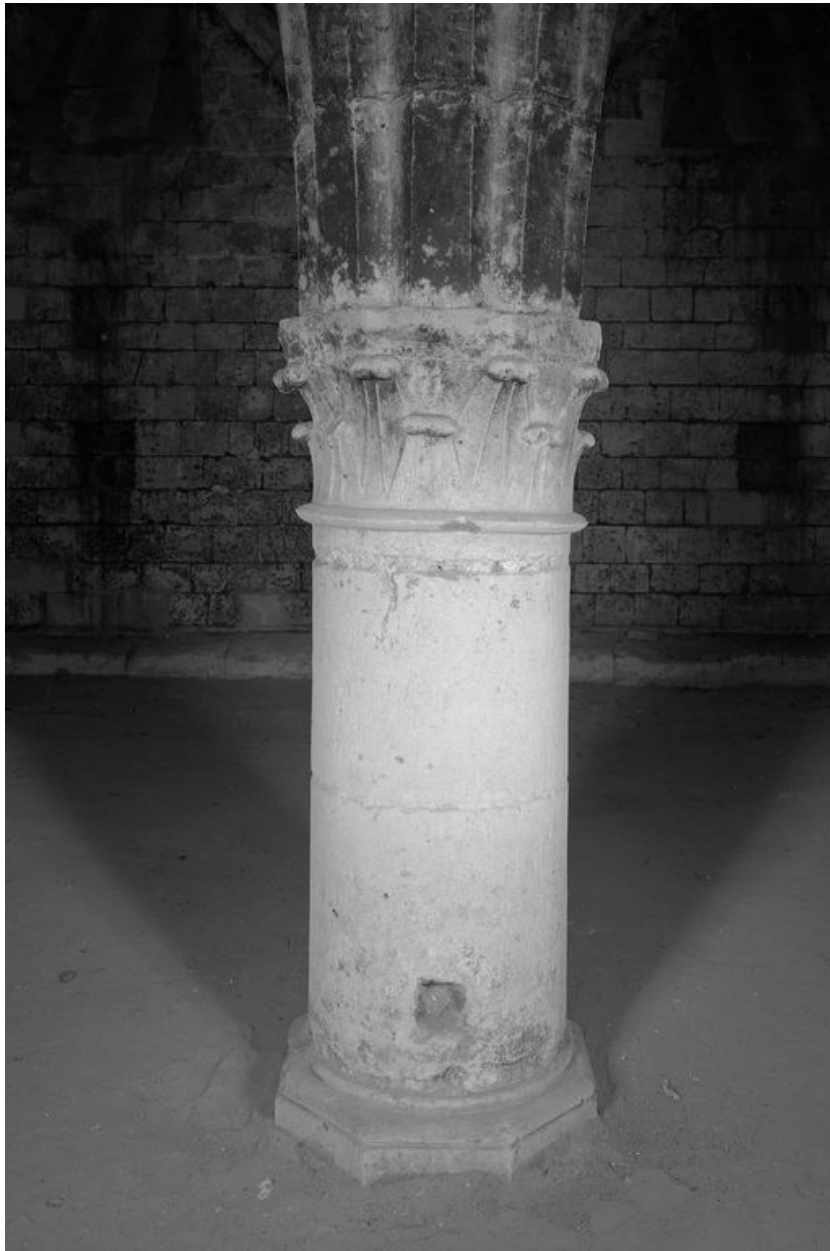
Le cellier. Vue du pilier central n°2.
