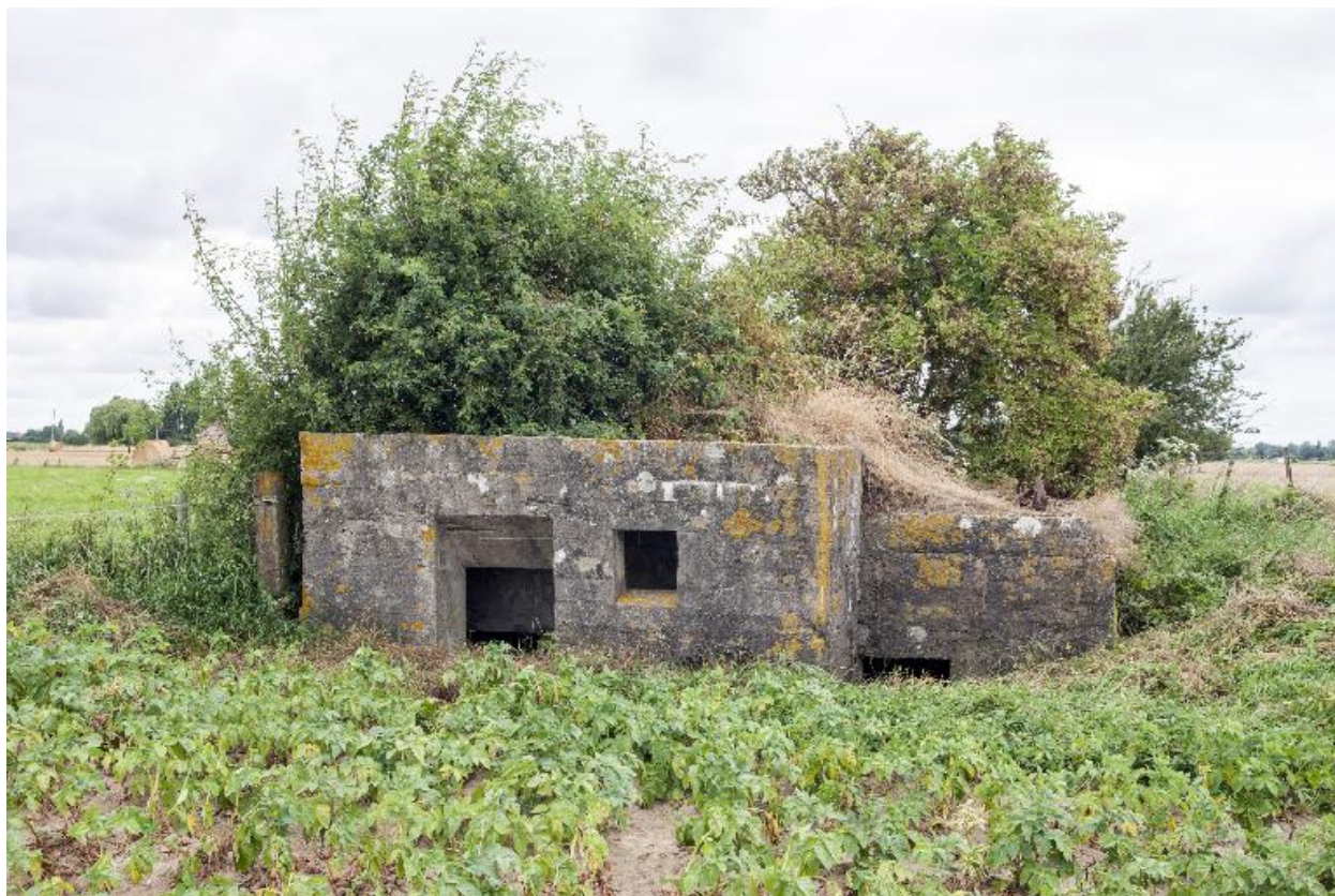
Vue de trois-quarts vers le nord
