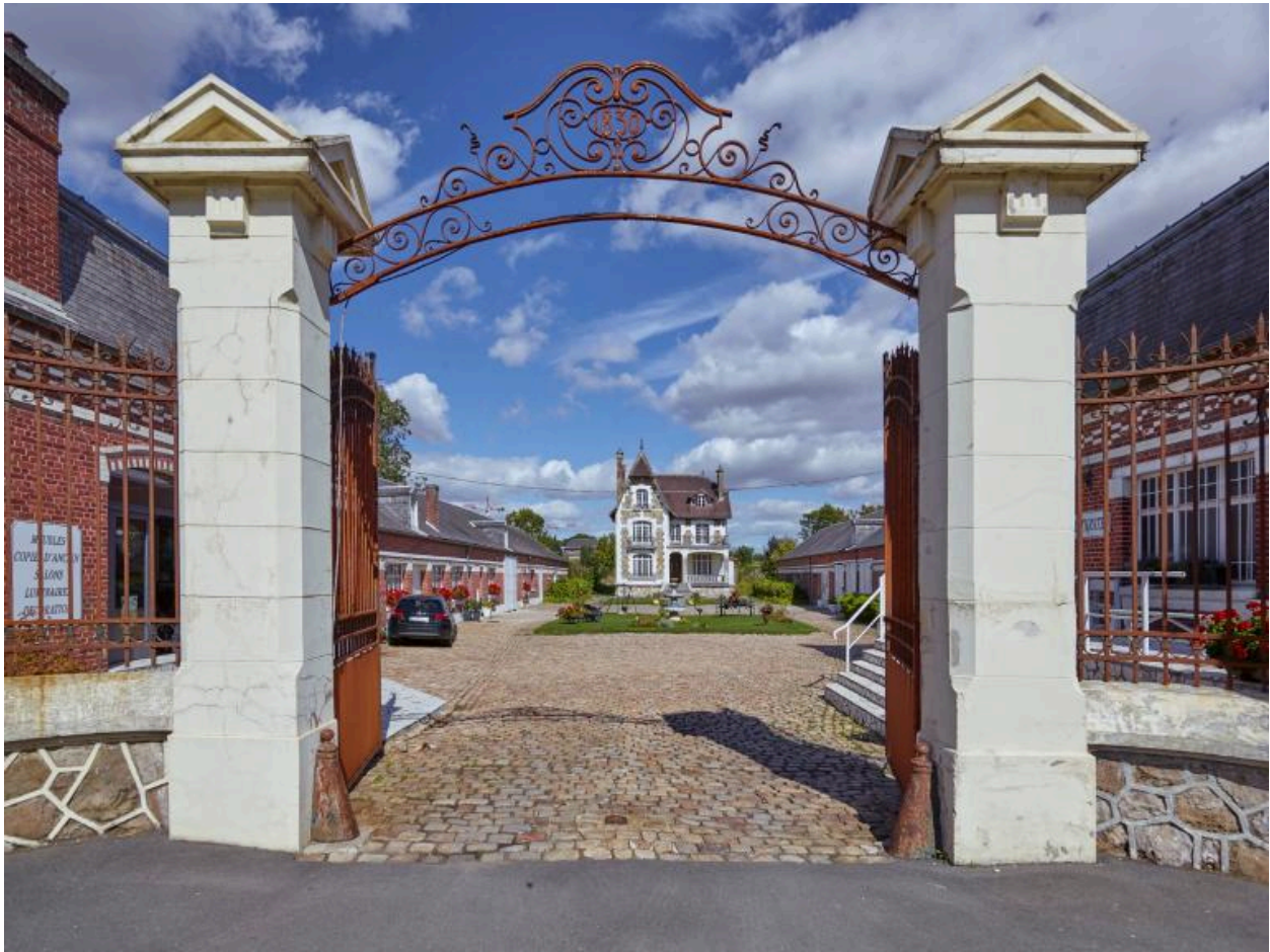
Vue axiale de la propriété depuis la rue du Faubourg de Péronne, depuis le portail d'entrée de la cour jusqu'à la villa.
