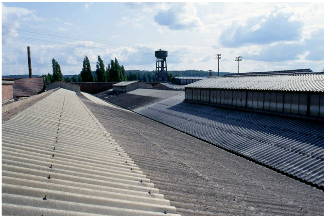
Toitures des ateliers de la Cerabati, 1992.
