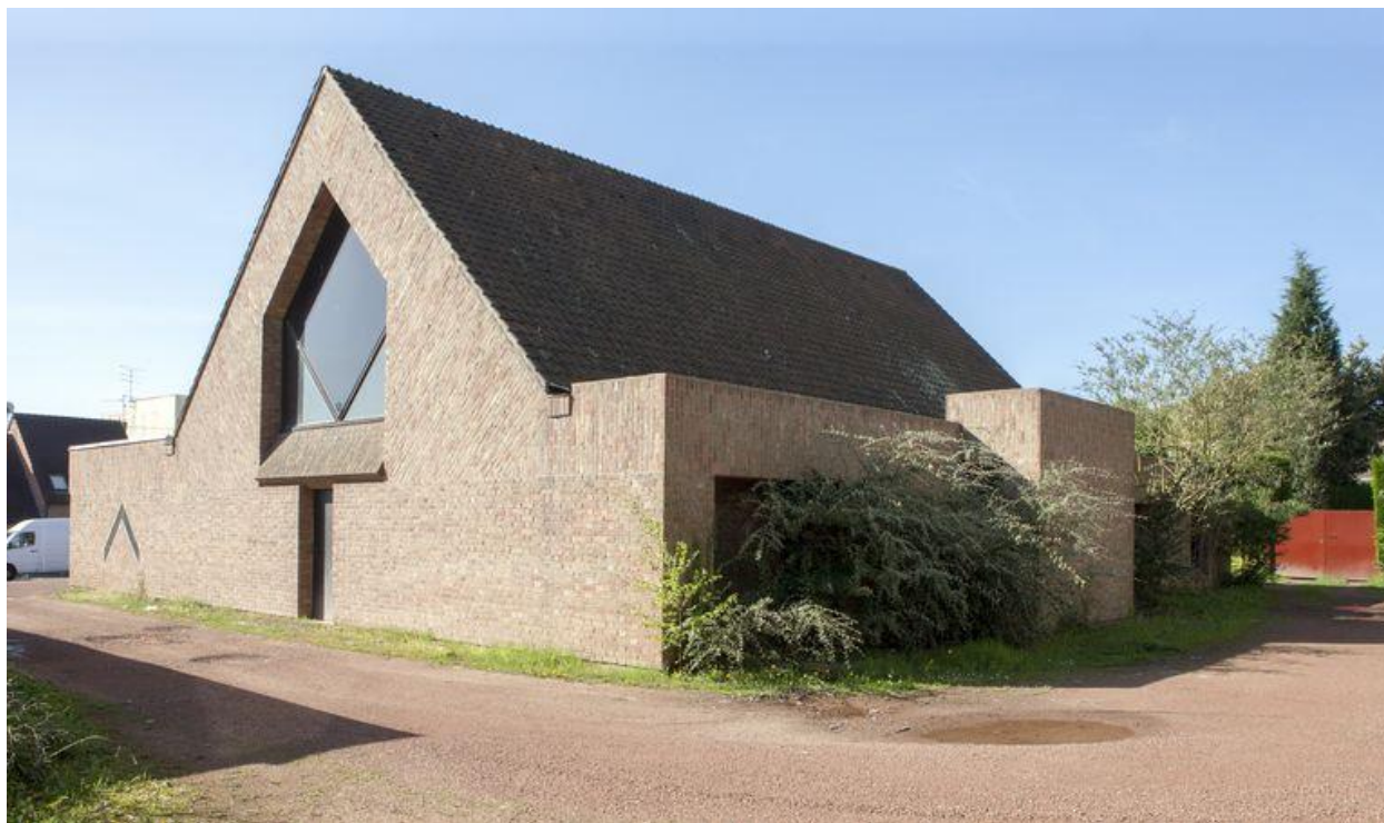
Élévation postérieure de l'église et flanc droit.
