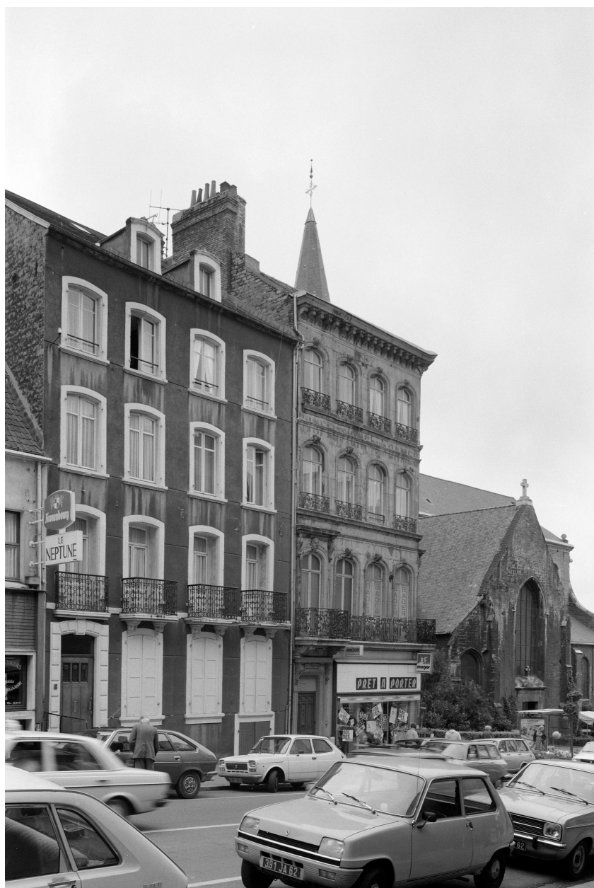
Immeuble, vue générale sur Grande Rue.
