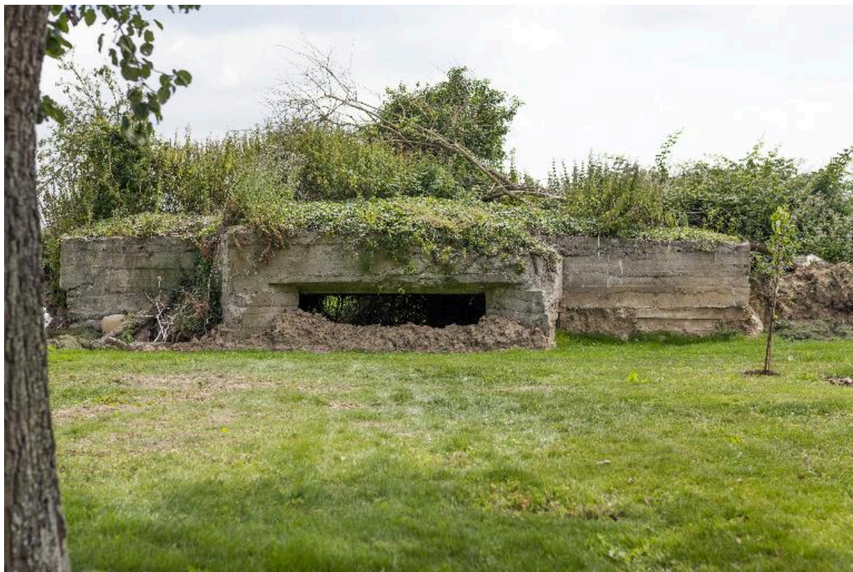
Vue frontale vers le sud-est
