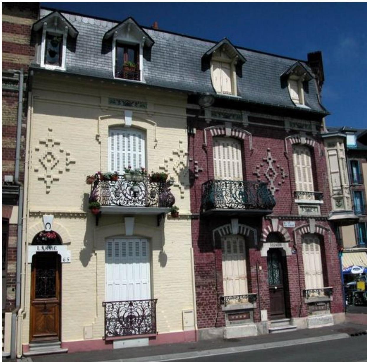
Vue depuis la rue Paul-Viguiér.
