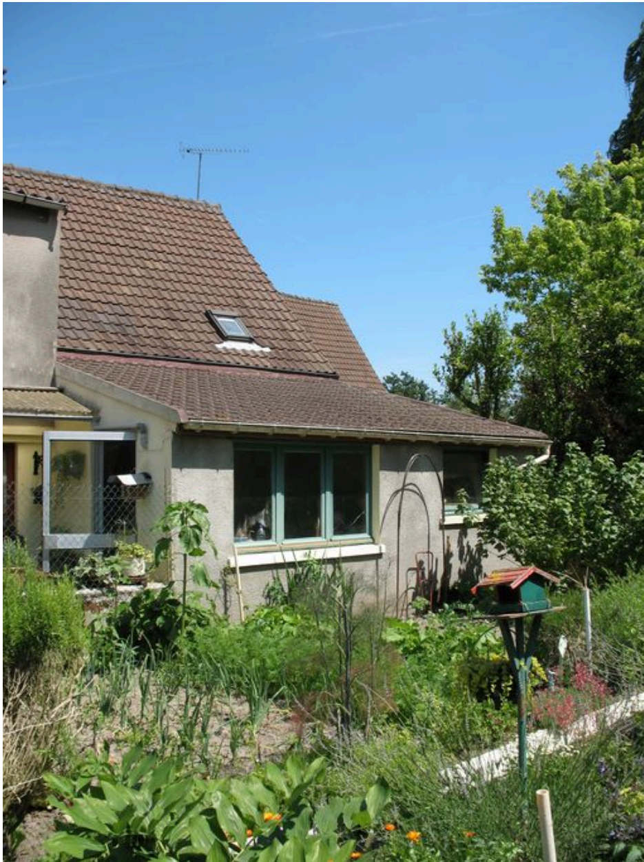
Vue générale du bâtiment qui abritait l'ancienne distillerie.
