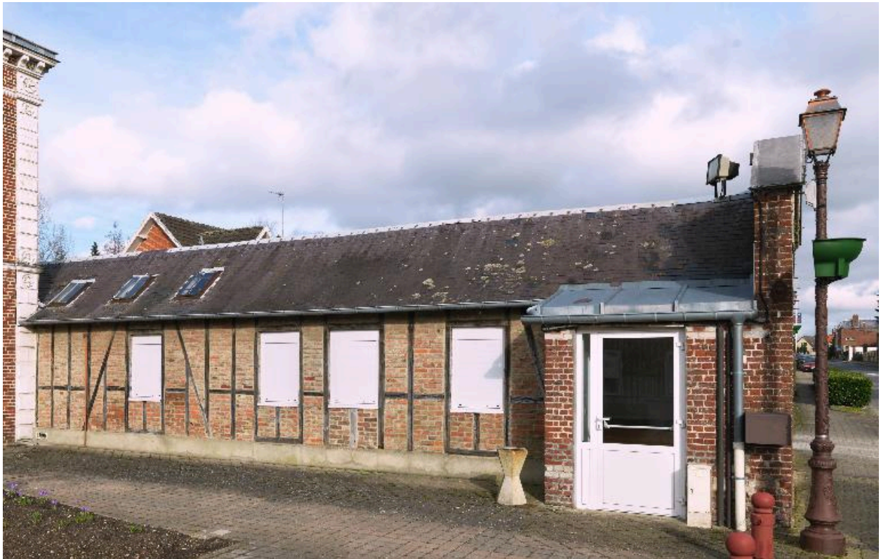
Vue générale des anciennes dépendances attenantes.
