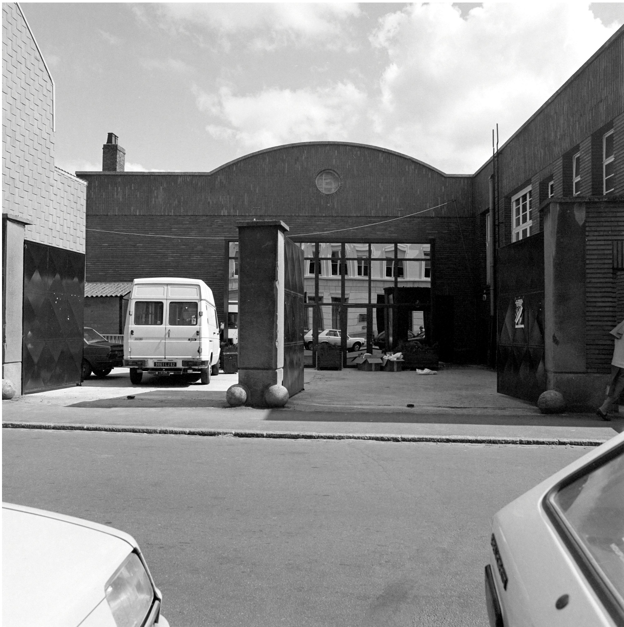
Atelier de fabrication, rue Sadi-Carnot.
