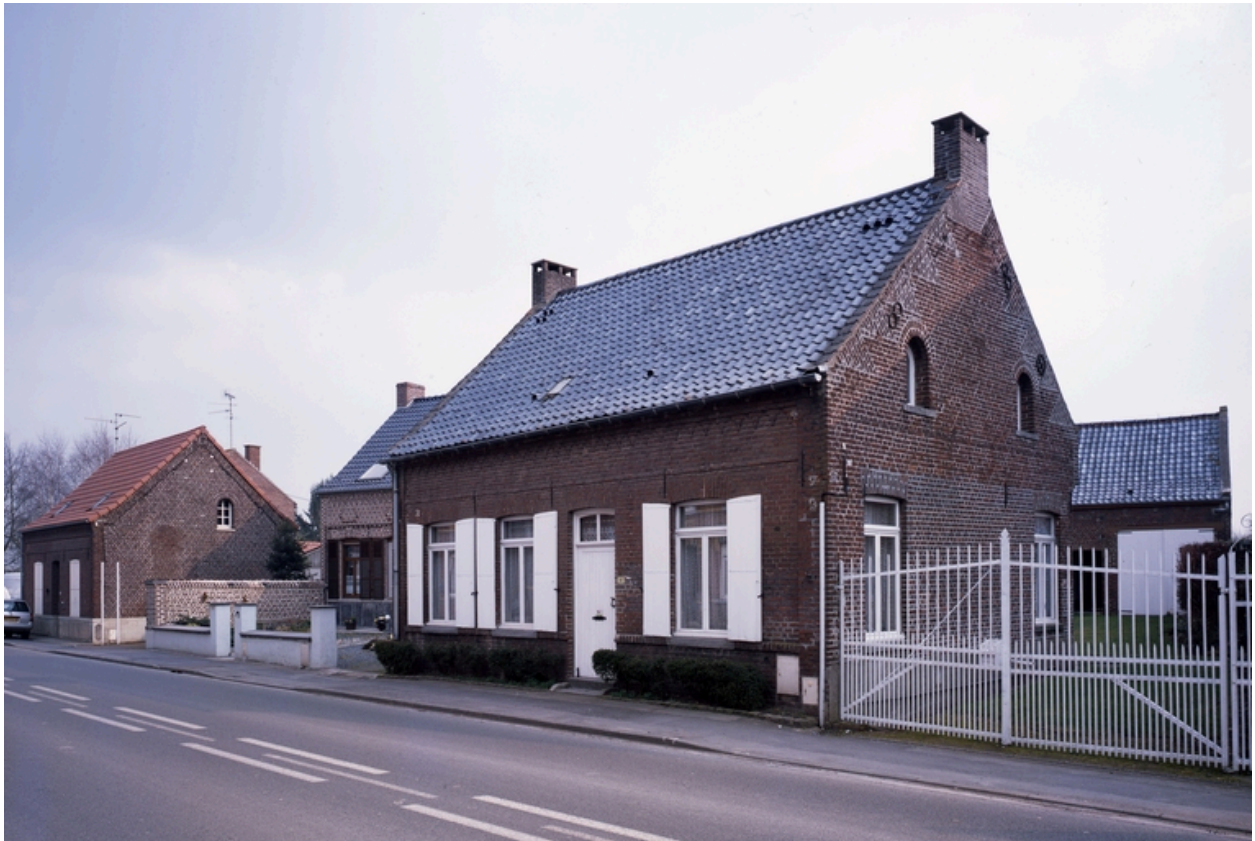
Vue générale d'une maison élémentaire.
