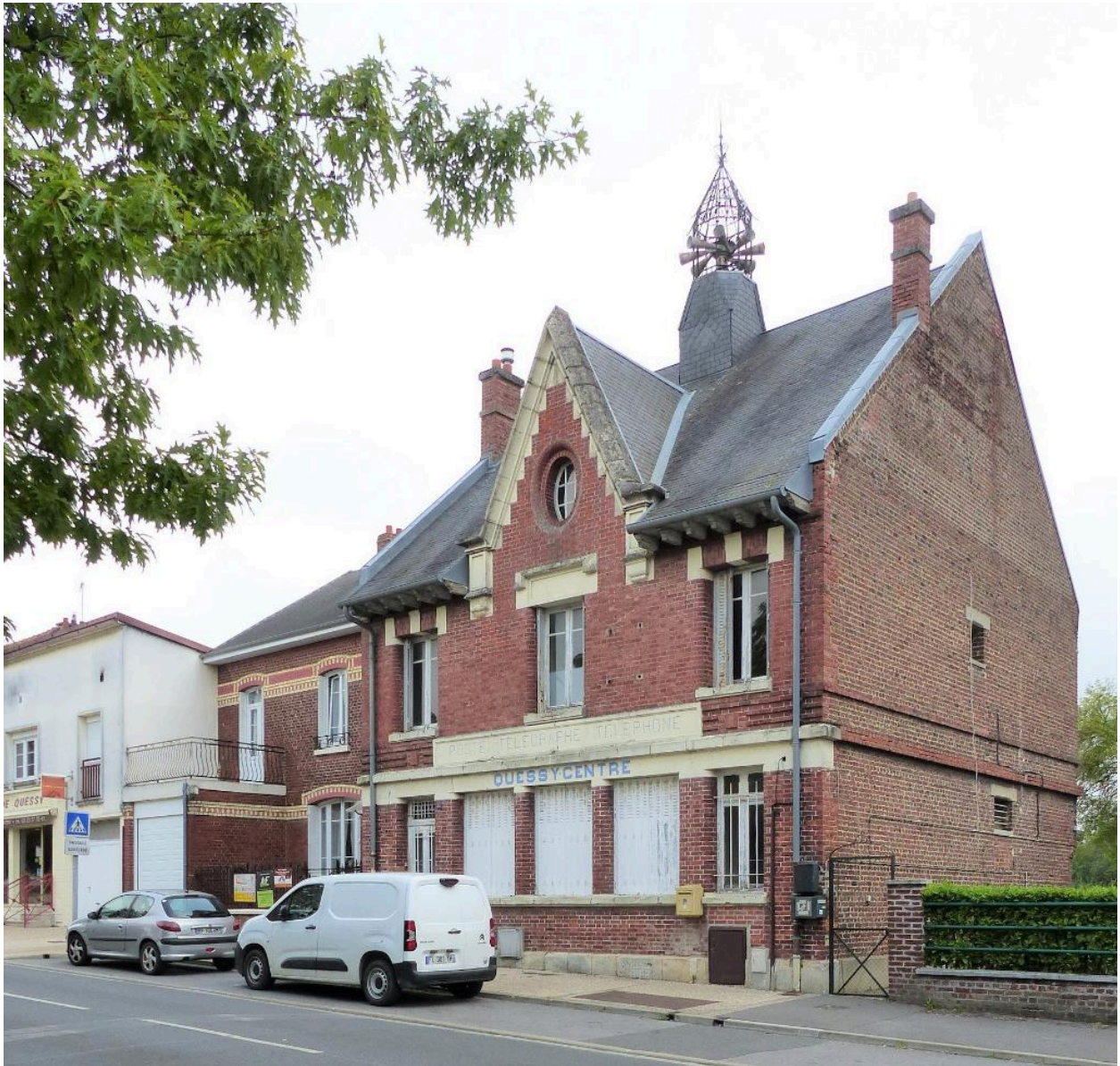
Vue générale depuis le sud-ouest.
