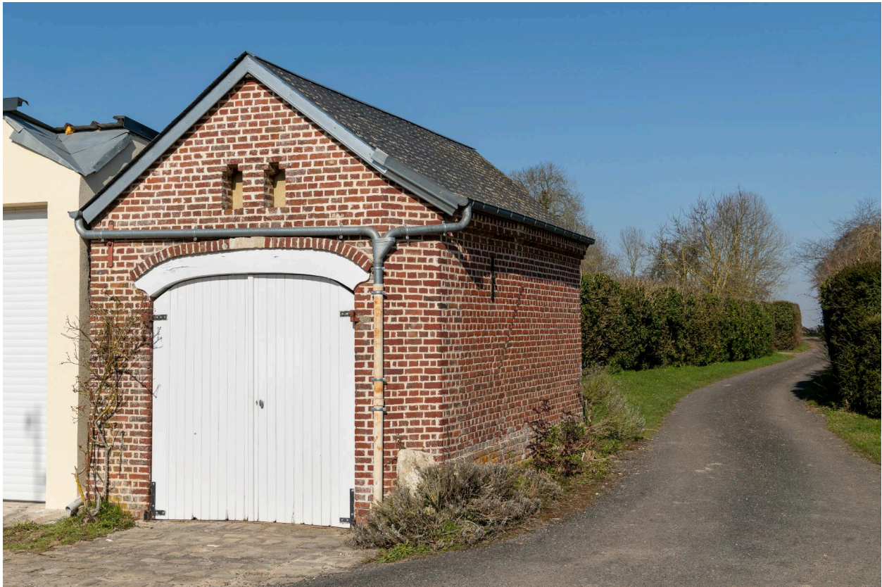
Bâtiment des pompes de la Neuve-Rue.
