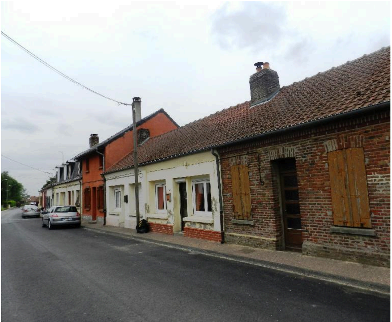
Vue générale, depuis l'est.
