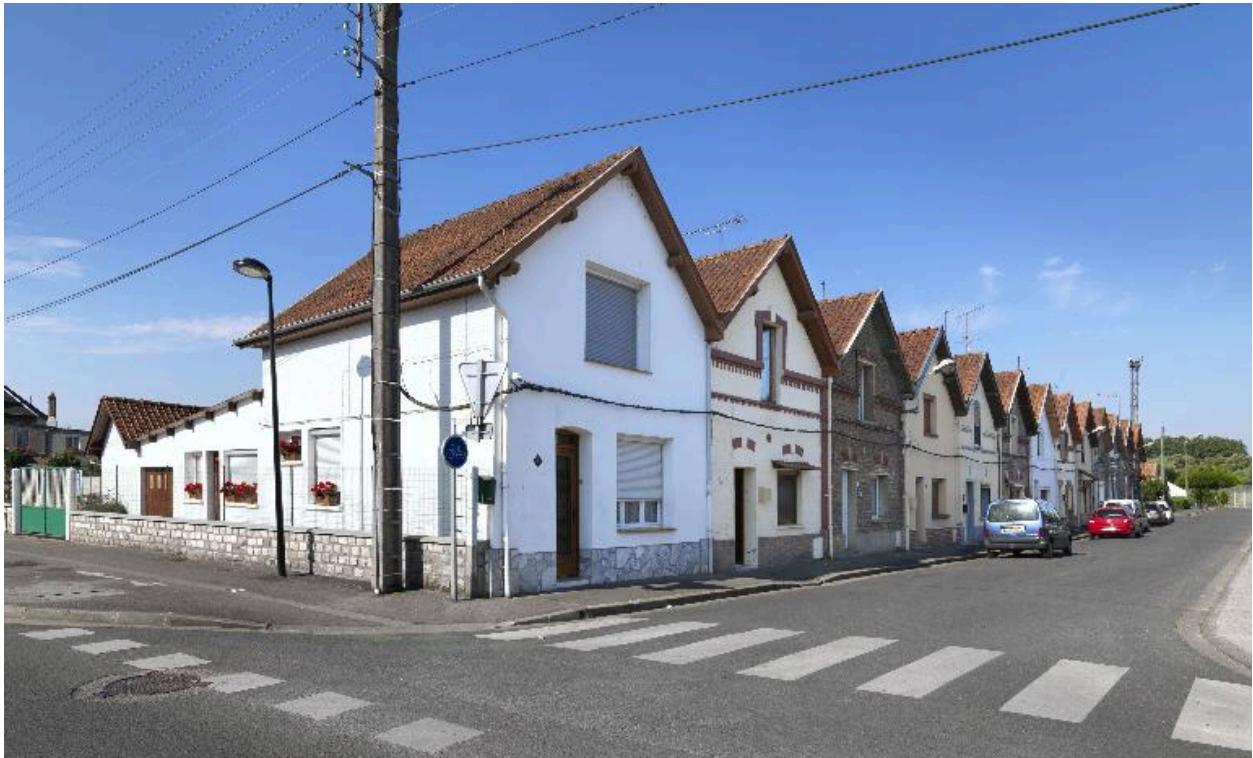
Logements ouvriers de la rue Nouvelle-Cité-Saint.
