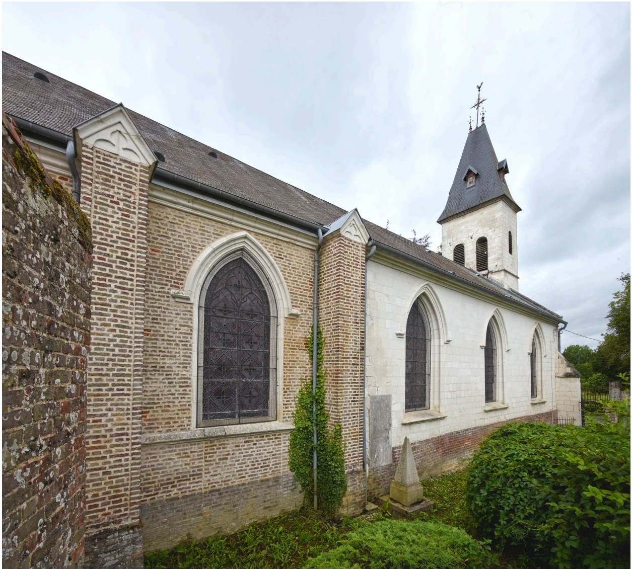
Vue de l'église, depuis le nord-ouest.
