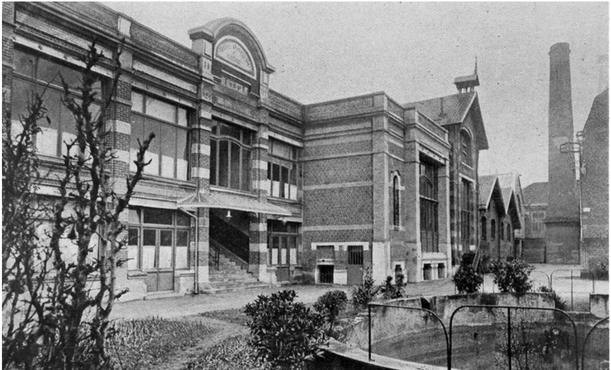
Cour de l'usine après restauration, vers 1921 (Le Monde Illustré).
