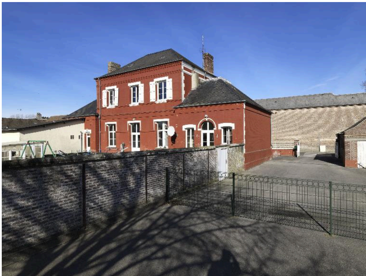
Vue de trois-quarts de la façade postérieure.
