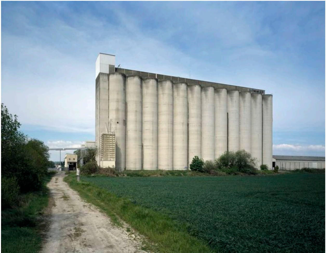
Vue générale des silos de la SEMMAP.
