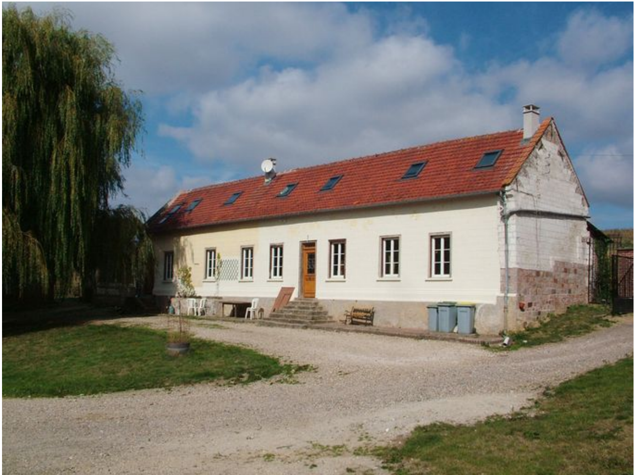
Vue du logis sur la cour.
