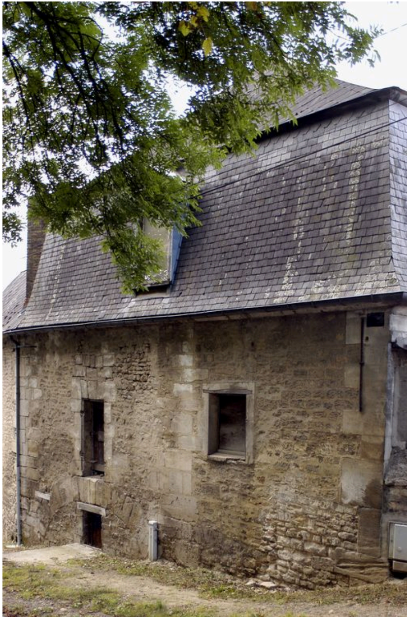
Pignon sur rue du moulin hydraulique et des ateliers de la filature attenants.
