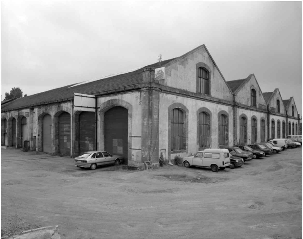
Entrepôts de réparation des locomotives : vue du nord.
