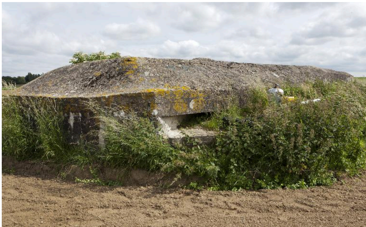
Créneau de fustillade, vers le sud
