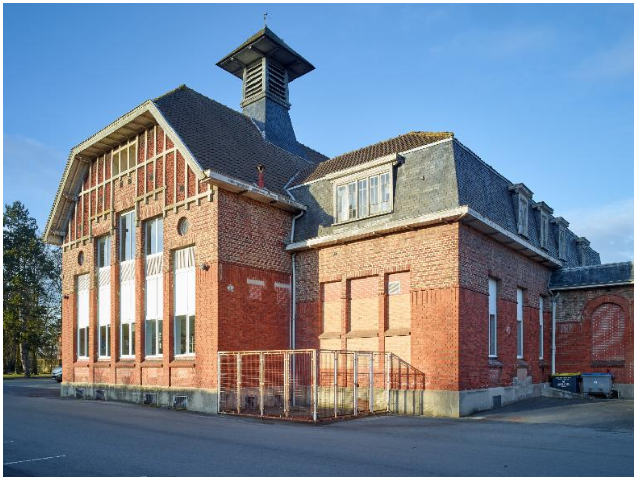
Bâtiment des cuisines, élévation antérieure, détail de la partie centrale, vue prise de trois quarts droit.
