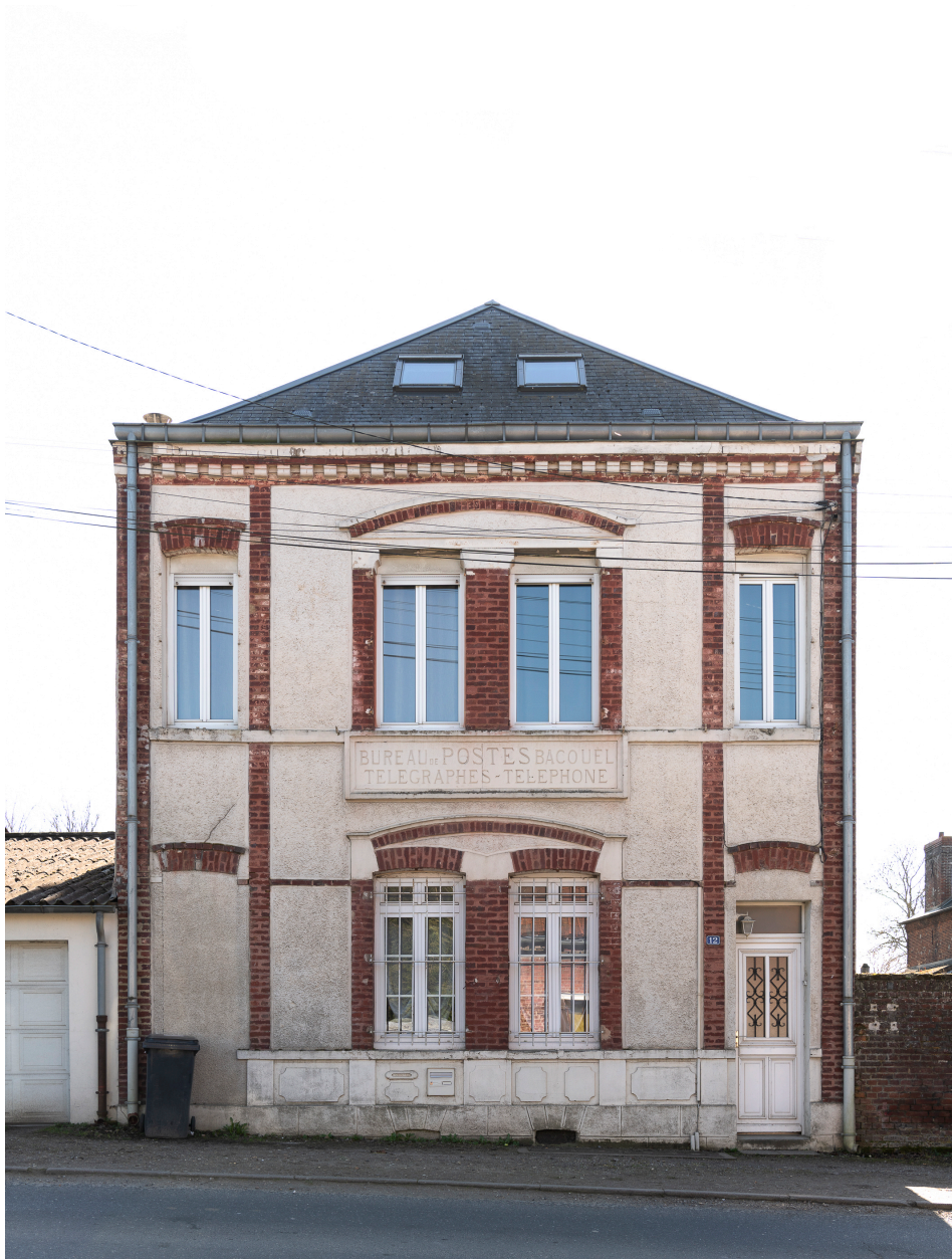
Ancien bureau de poste, n°12 de la rue de Montdidier, vue depuis le nord.
