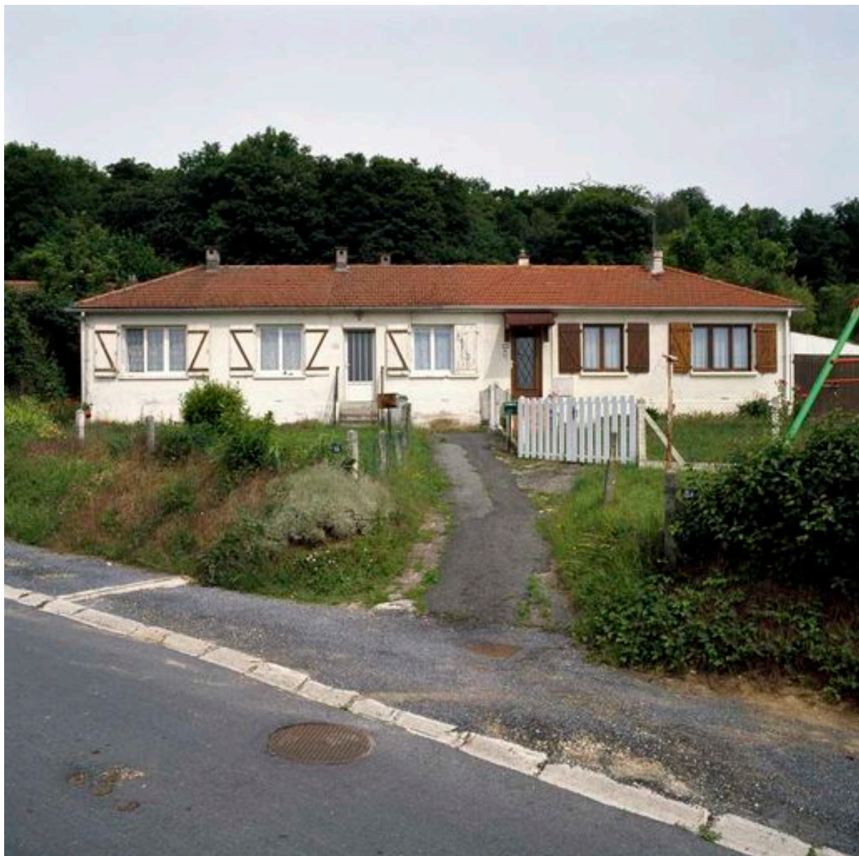
Maison jumelée en haut de la cité l'Epine.
