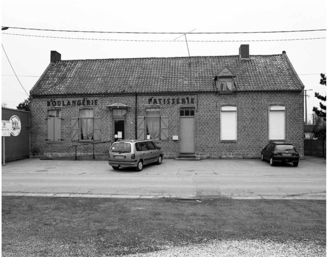
Vue générale, élévation antérieure.
