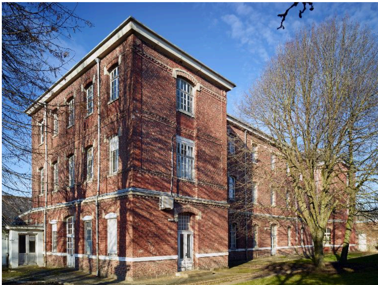
Bâtiment d'hospitalisation dit pavillon 6, élévations antérieure et latérale gauche donnant sur le jardin, vue d'ensemble.
