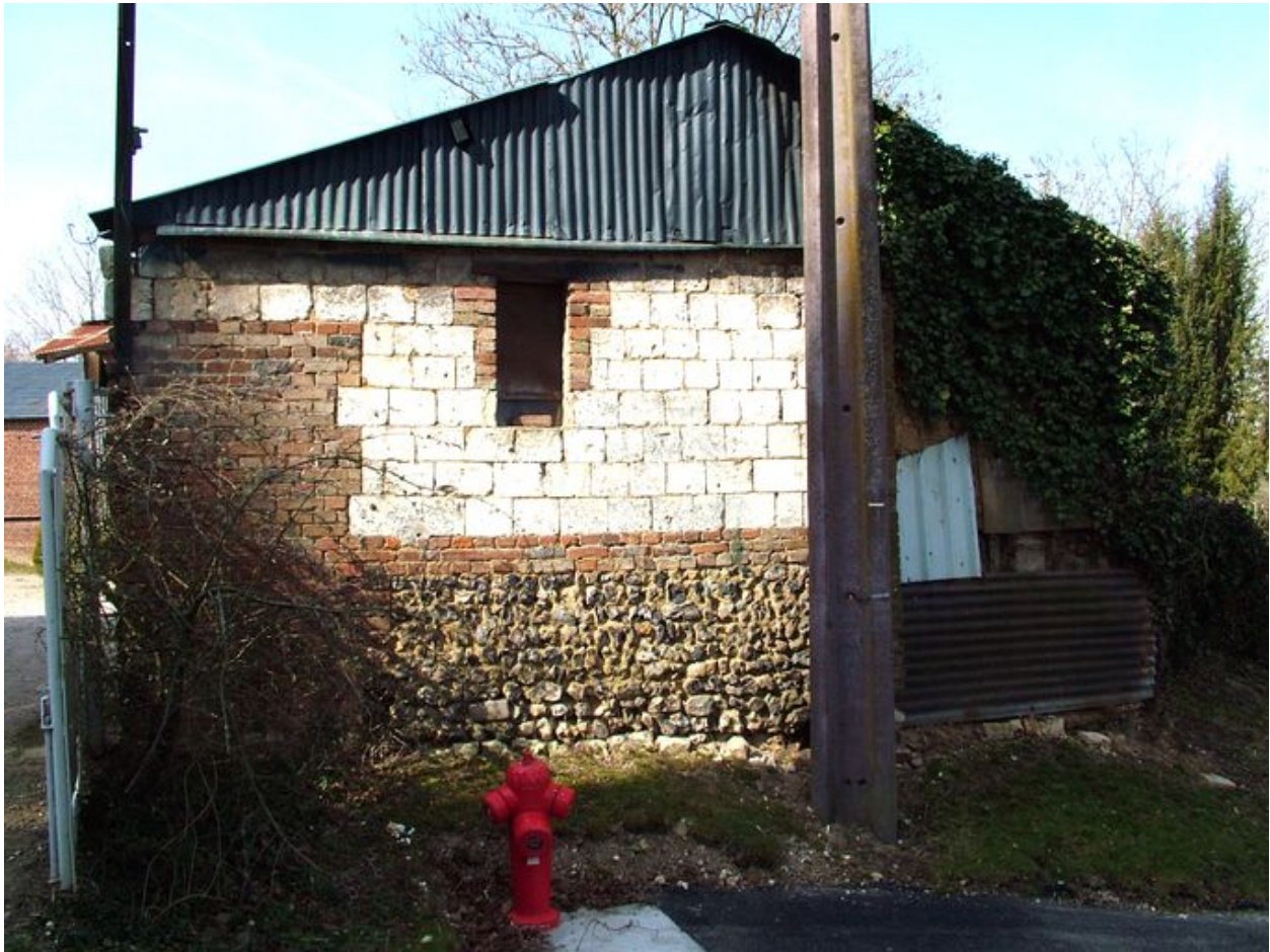
Pignon sur rue de l'ancienne étable.
