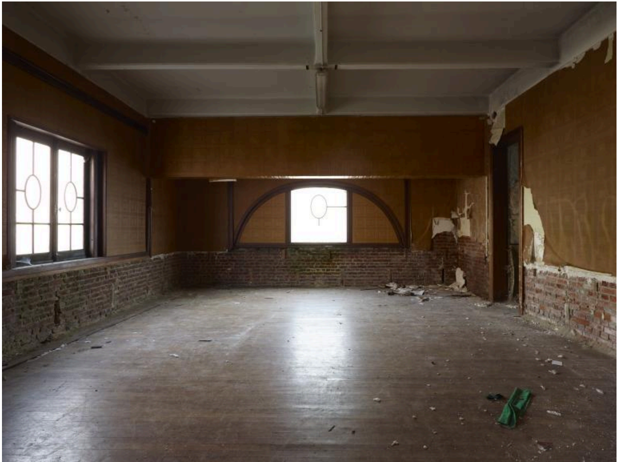
Bureaux. Une salle du premier étage.
